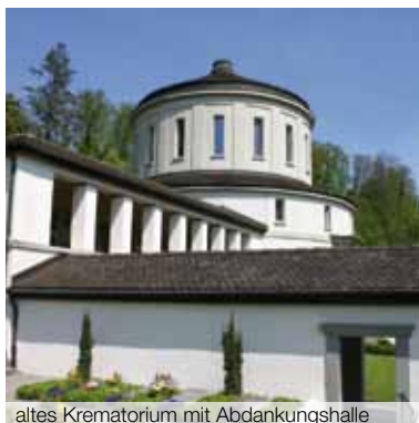
altes Krematorium mit Abdankungshalle
